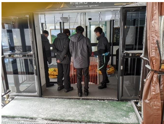
落下対策用防護柵の設置
